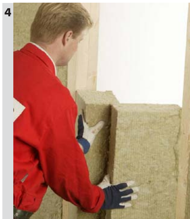
montaż izolacji z dwóch płyt
