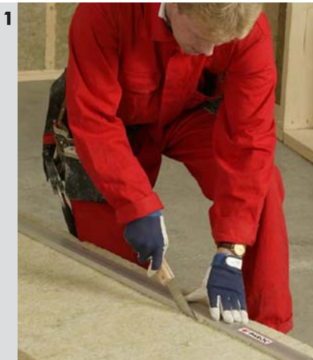
cięcie płyt PAROC do odpowiedniego wymiaru
