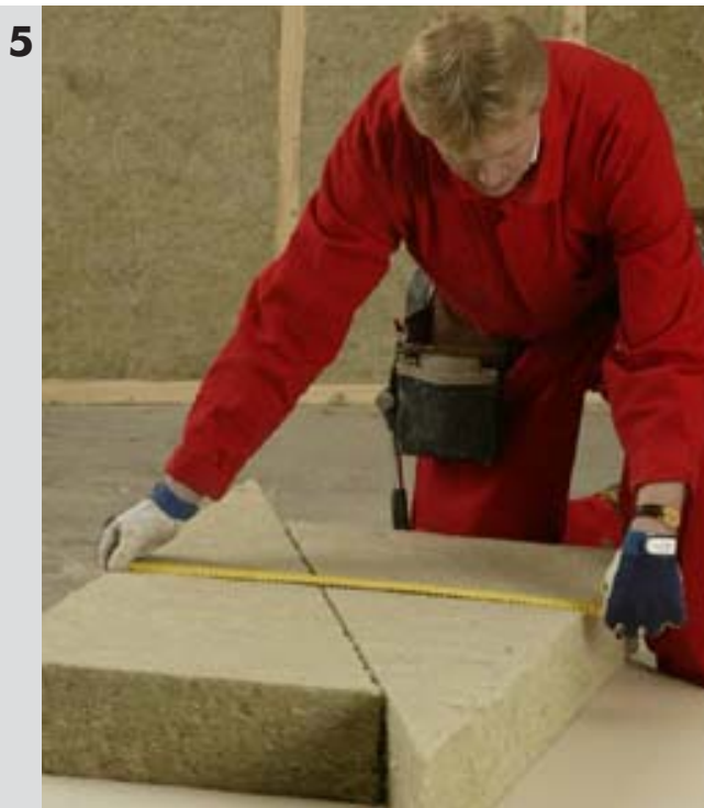
wykorzystanie odpadów poprzez układanie izolacji z trójkątów
