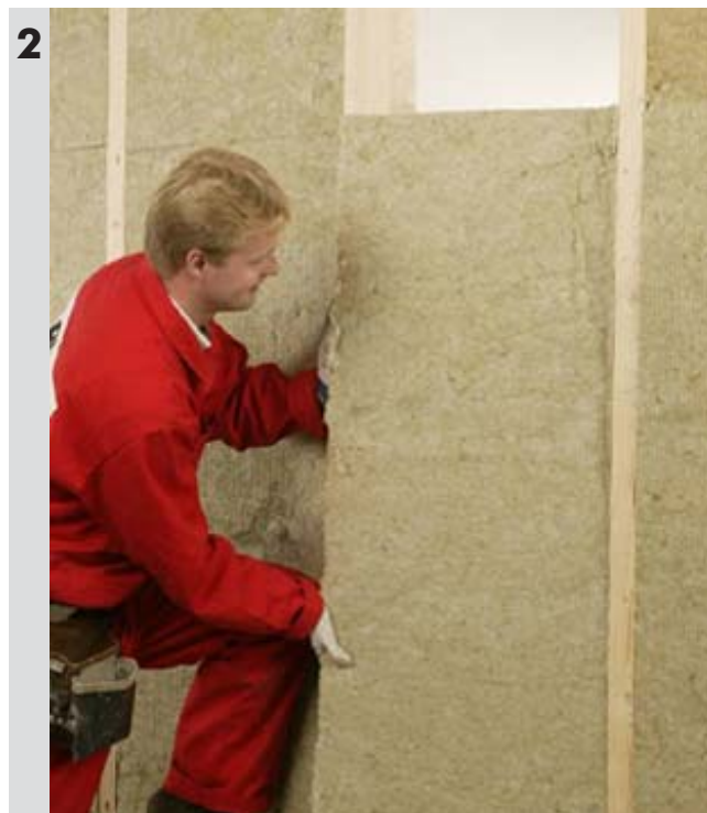
montaż płyt w szkieletcie ściany
